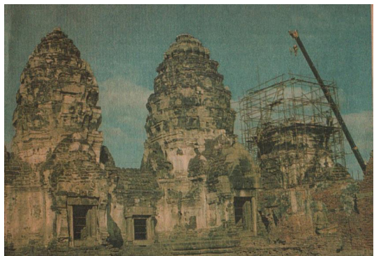
พระปรางค์สามยอดขณะที่กำลังบูรณะ
